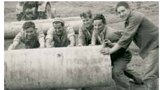
Bassigger Bauern helfen beim Aufstellen der Seilbahnstützen
